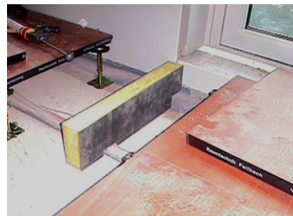
Auch Einschnitte/Ausklunkungen für Leistungs- und Rohrdurchführungen sind kein Problem
