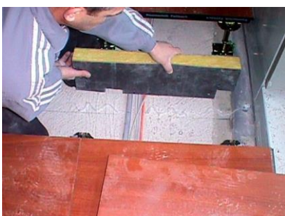
Als Montagehilfe, Fixierung eignen sich Dichtungsmassen, Montageschäume usw.
